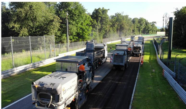
da assicurare la piena conformità del prodotto e dell'opera in campo. Il test è stato fondamentale per verificare alcuni parametri speciali come la rugosità superficiale/aderenza e la capacità di far defluire le acque superficialmente.
